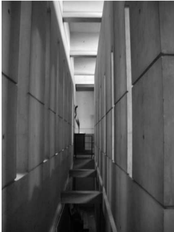
Entre le mur extérieur et le mur de meurtrières
