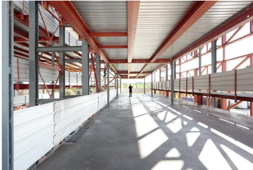
Fig. 16 : LUCAT Marie-Caroline, chantier du RBC Design Center, Montpellier, (architectes : Atelier Jean Nouvel), 2010-2012.
