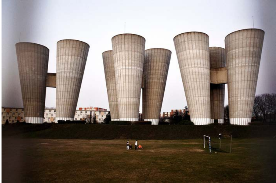
Fig. 34 : CORNUT Cyrus, Châteaux d'eau, Villejuif, 2008 , photographie extraite de la série Voyages en périphérie .
