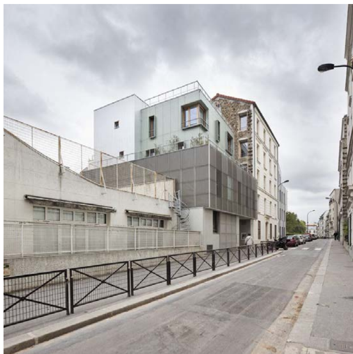
Fig. 14 : FILLON Vincent, Crèche, Paris (architectes : Hardel Le Bihan), 2013.
