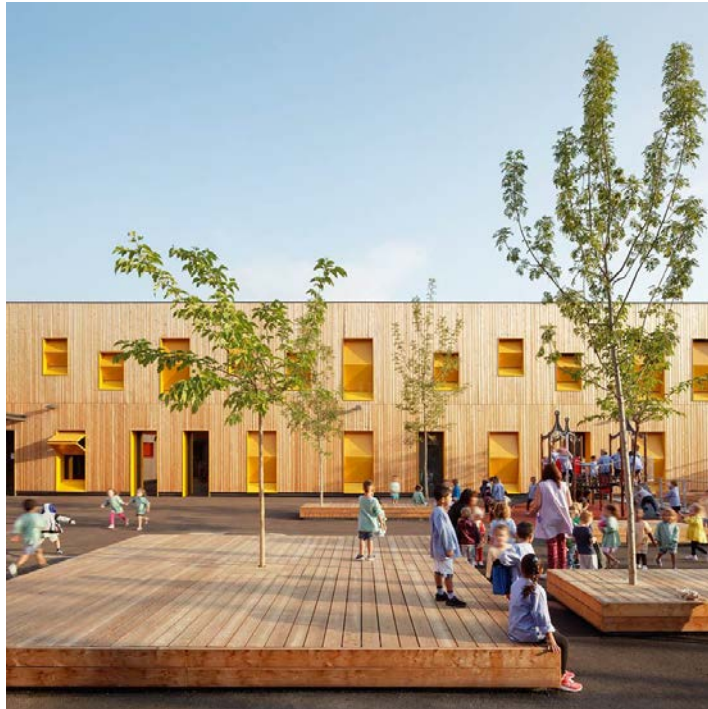
Fig. 13 : FILLON Vincent, École maternelle, Nice (architectes : AMNA), 2017.
