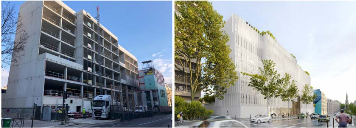
Fig. 22 : Photographie de chantier / Image de synthèse, Futur siège social du groupe VYV, Paris (architectes : CALQ), 2021.
