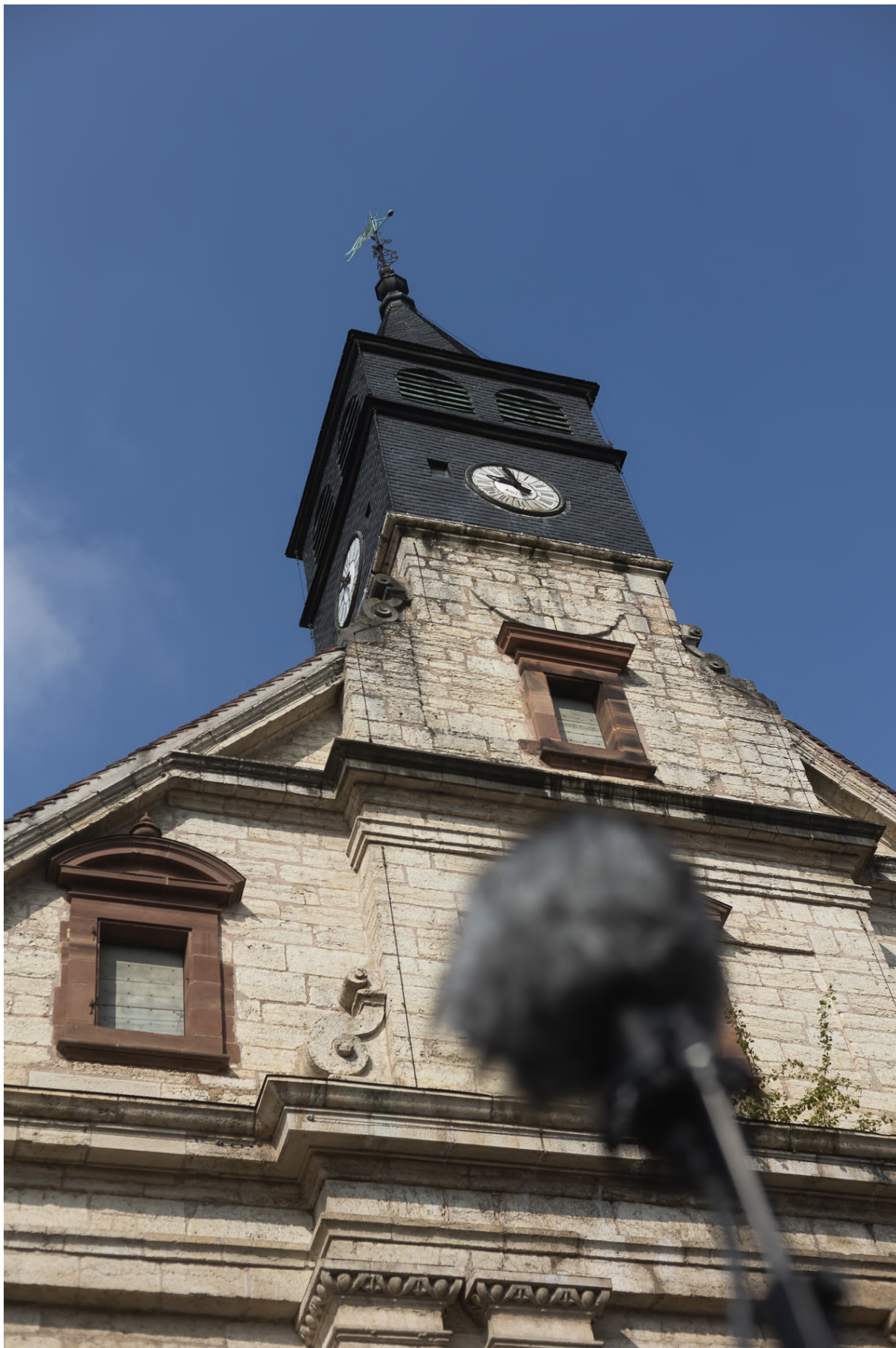
Figure 34 : Photographie de la mise en place du système de prise de son de la cloche depuis le parvis du temple par Céline Bouquet
