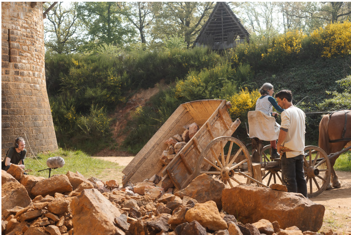
Figure 42 : Photographie de la mise en place du système de prise de son d'un dépôt de pierres par Céline Bouquet
