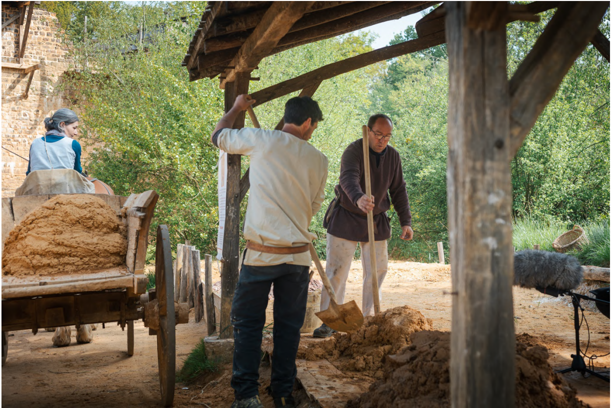
Figure 40 : Photographie de la mise en place du système de prise de son d'un remplissage de mortier par Céline Bouquet
