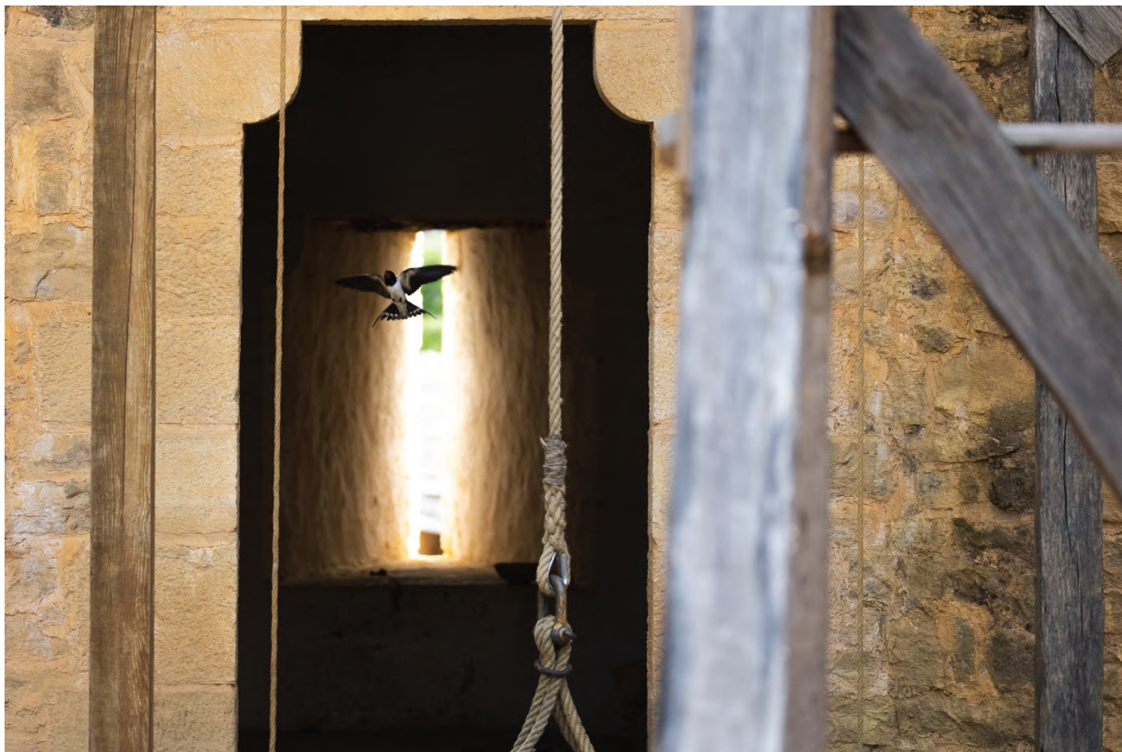
Figure 44 : Photographie d'une hirondelle nichant dans l'une des tours en construction par Céline Bouquet
