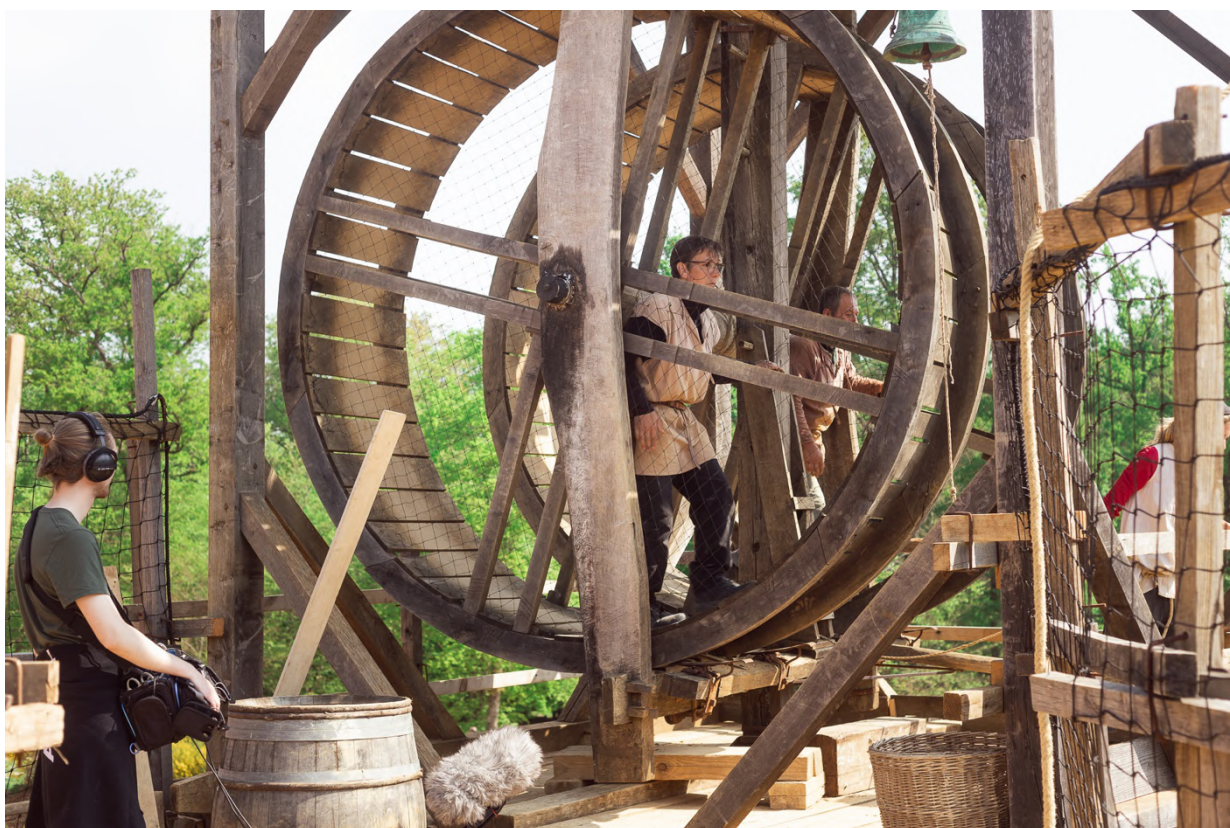
Figure 39 : Photographie de la mise en place du système de prise de son d'un système de grue appelé « cage à écureuil » à double tambour par Céline Bouquet
