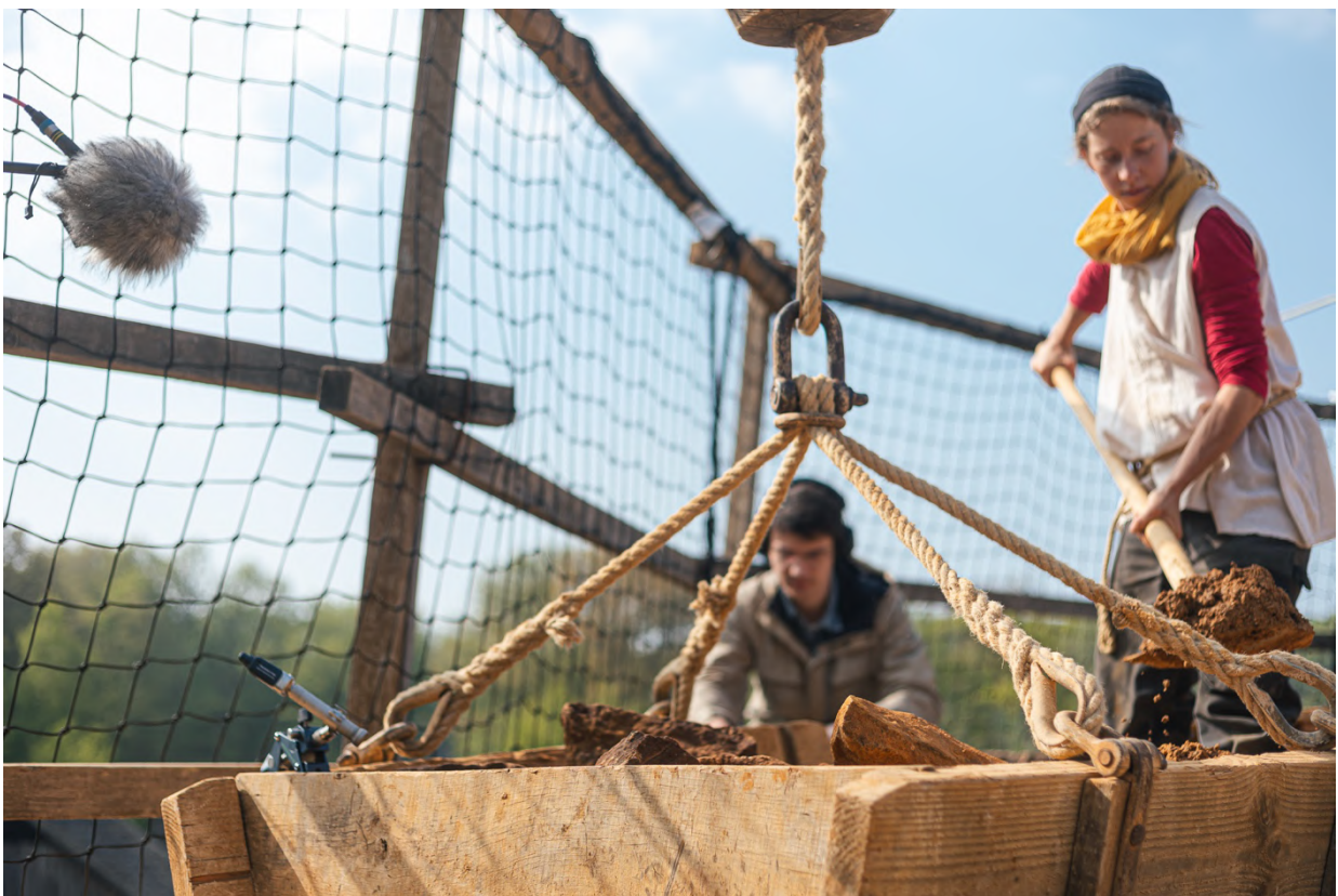
Figure 41 : Photographie de la mise en place du système de prise de son d'un remplissage de mortier par Céline Bouquet
