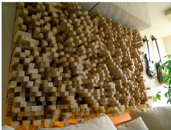
FIGURE 4 – Exemple d'un diffuseur de Schroeder bi-dimensionnel. Les différences de niveau entre les éléments favorisent le phénomène de diffraction pour les longueurs d'onde concernées.
