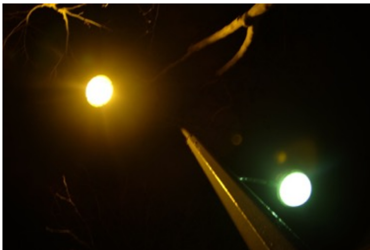
Un lampadaire pourvu d'une source au sodium et d'une source au mercure à Paris (photographie personnelle 28 , à 4200K - 1/8s - f/1.4 - iso 400)
