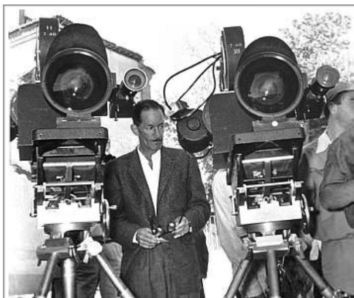
Le chef opérateur Lionel Lindon, A.S.C entre deux caméras 65mm équipées d'objectifs Bug-eye sur le tournage du Tour du monde en 80 jours . Une caméra tourne à 30 i/s, l'autre à 24 i/s
