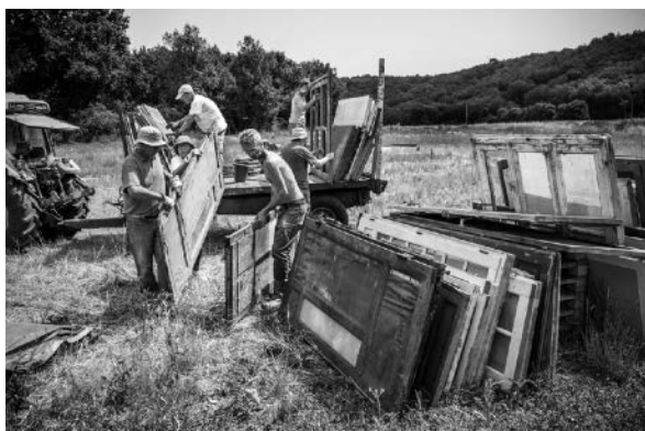
Figure 32 : JACOB Mat, Construction du Labyrinthe de Zone i , Thoré-la-Rochette, photographie numérique, 2019
