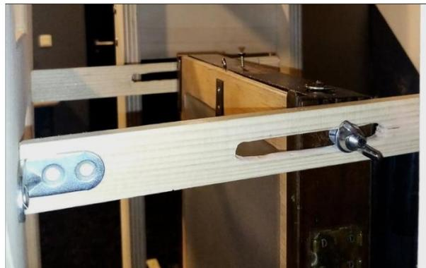
*Photographie des languettes de maintien installées.*
