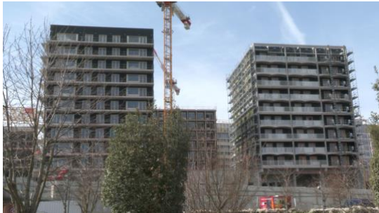
Extrait n°1 : Quartier en travaux
