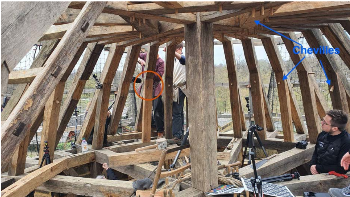
Illustration 14 : Dans la charpente du pigeonnier, Stéphane tente d'extraire la tarière coincée par Maxime, et lui explique son erreur. En rouge, l'assemblage tenon-mortaise, pour lequel il faut faire un trou (avec la tarière) destiné à insérer la cheville qui scelle l'assemblage (autres exemples en bleu). (Photographie de Patrick Baert, avril 2023)
