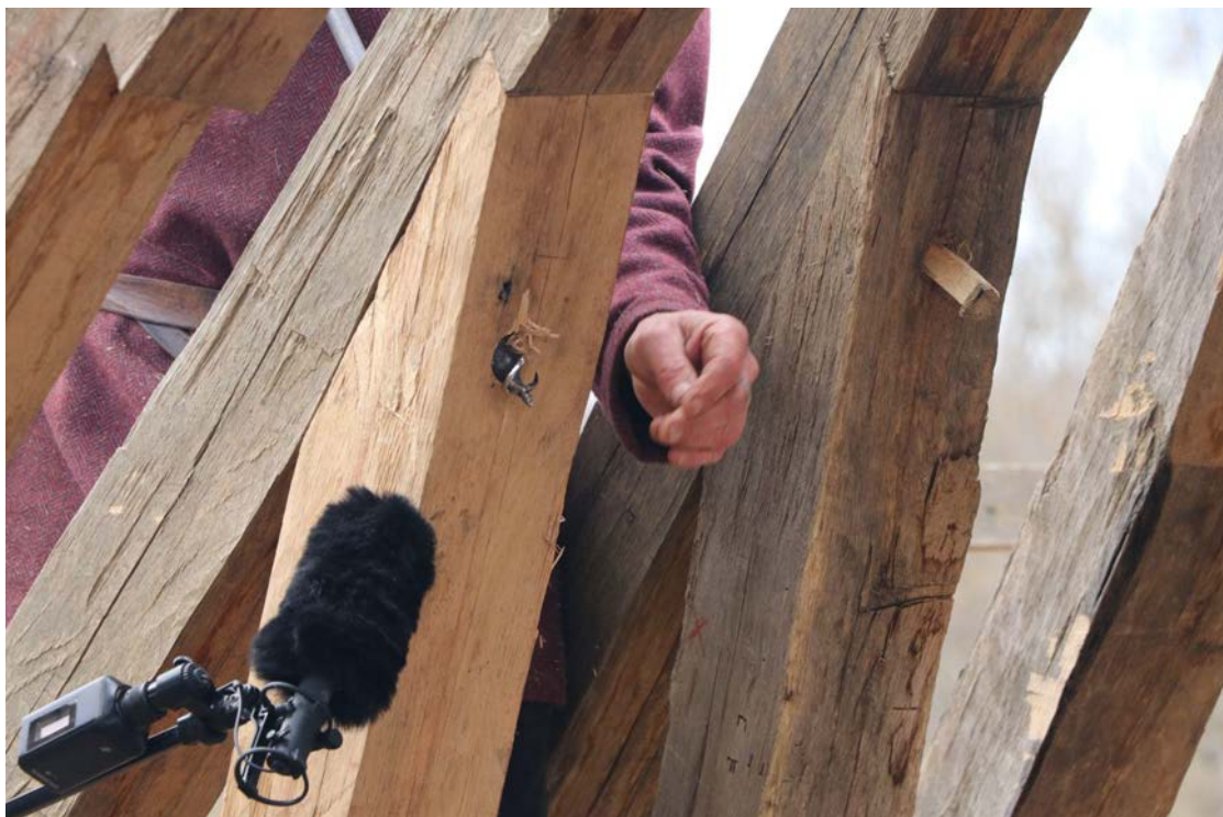
Illustration 21 : Stéphane répare les dégâts (© PI2A-Audio, 2023)
