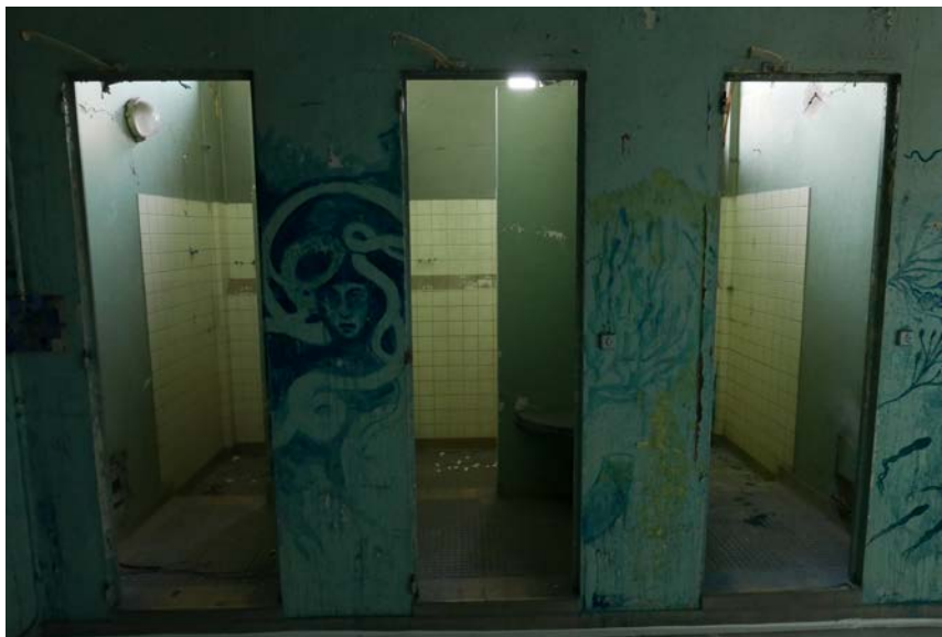
Figure 16. Douches de l'espace 1
