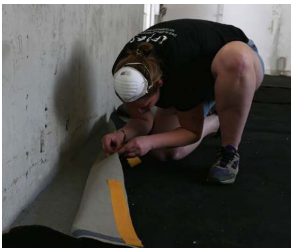
Figure 27. Installation de la moquette dans la pièce 3
