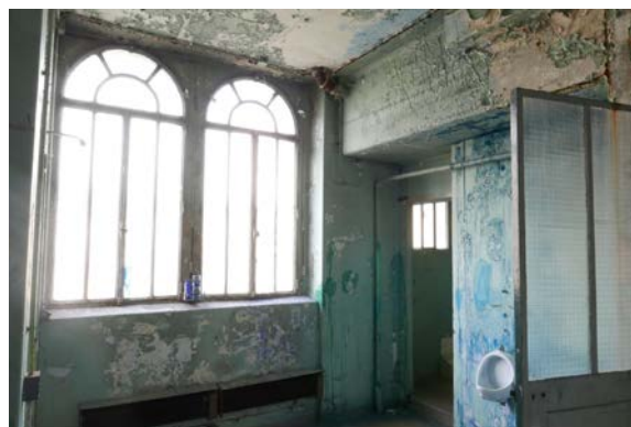
Figure 35. Fenêtres de l'espace 1
