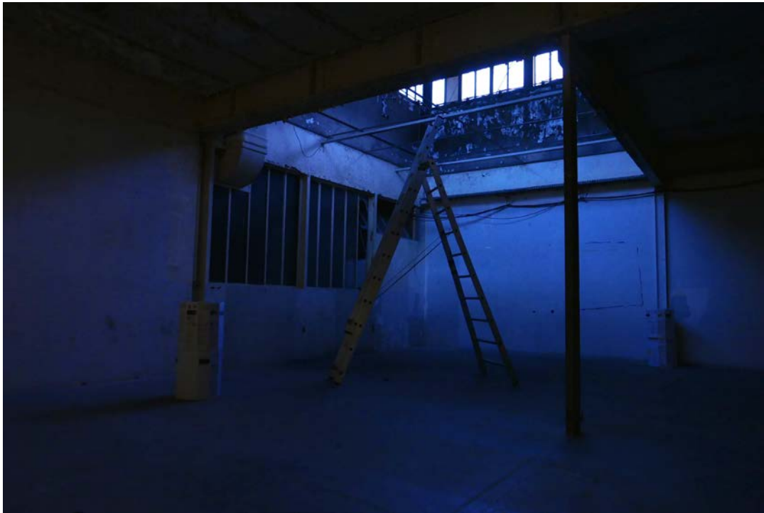
Figure 36. Puits de lumière espace 2
