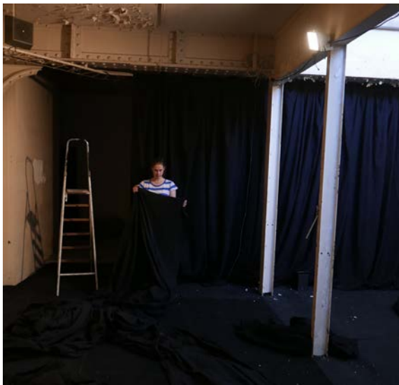
Figure 29. Installation des molletons dans l'espace 4
