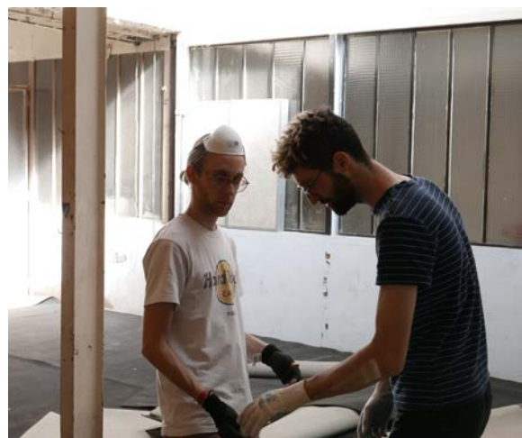
Figure 28. Installation de la moquette dans la pièce 3
