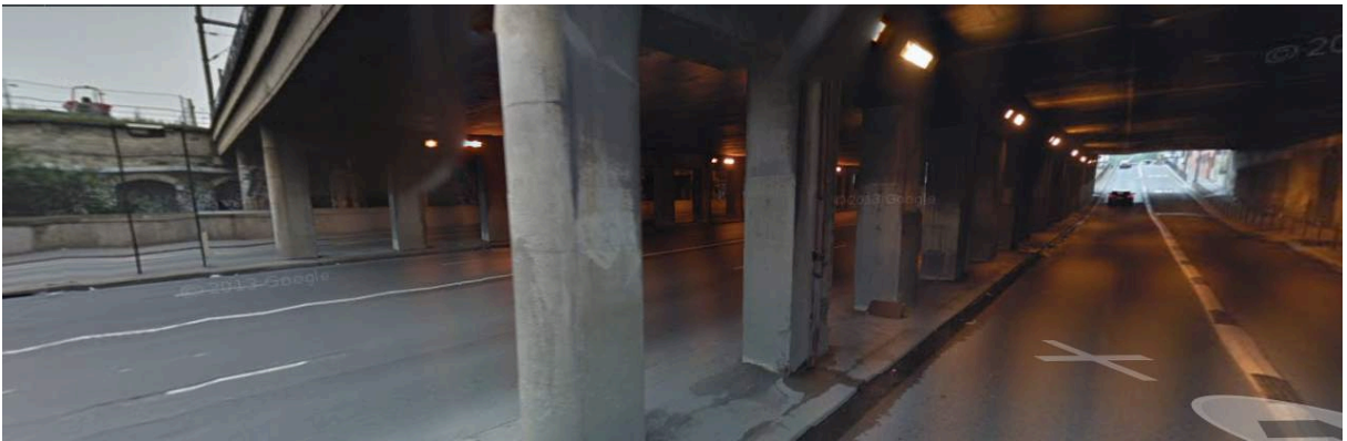
Figure 46 : Panoramique du tunnel du boulevard Ney.
