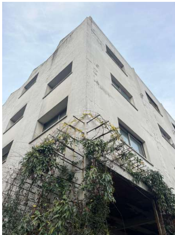
Extension du bâtiment construite en 1973
