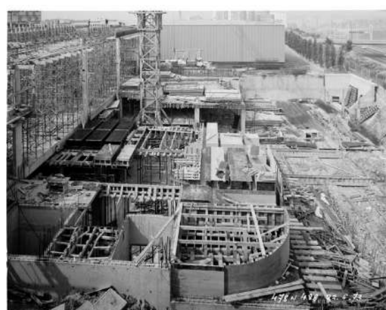
Construction de trois "Sheds", toiture à redents caractéristique des usines, 1973. Source : Camille Herzmann, Le Sample.
